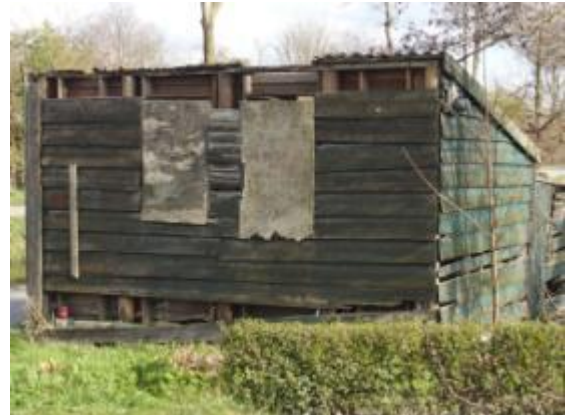
Westgevel en Zuidgevel
