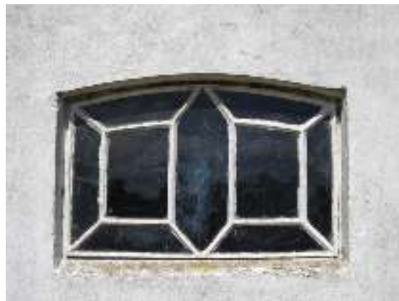
Detail gietijzeren raam oostgevel
