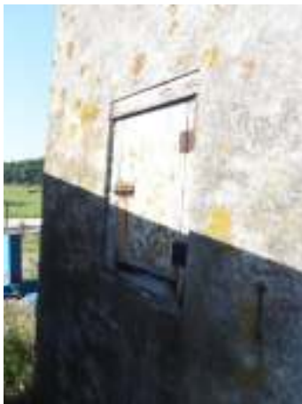
raamkozijn in oostgevel
