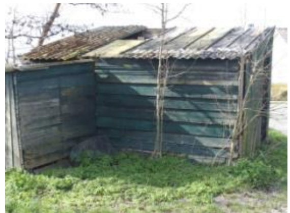
Oostgevel en Noordgevelpomphok
