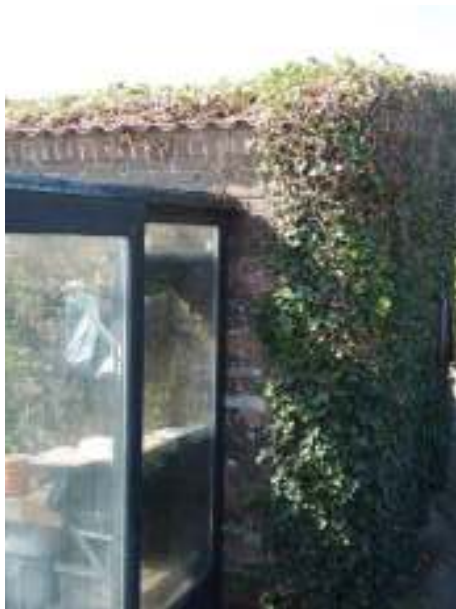
noordoost- en noordwestgevel
