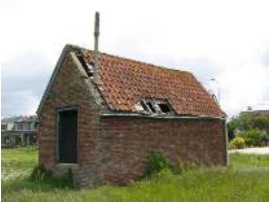
Zuidwestgevel en noordwestgevel
