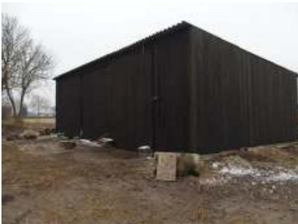
Noordoost- en noordwestgevel
