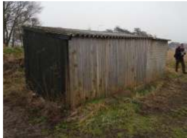
Noordoost- en Noordwestgevel
