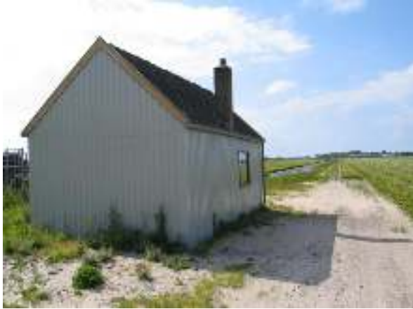
Zuidoostgevel en noordoostgevel
