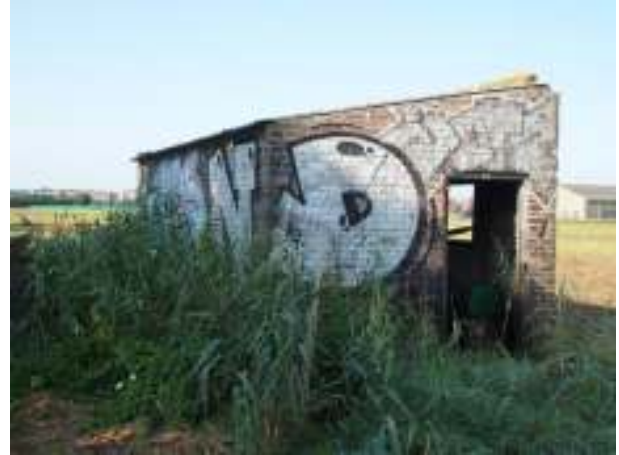
Noord- en oostgevel
