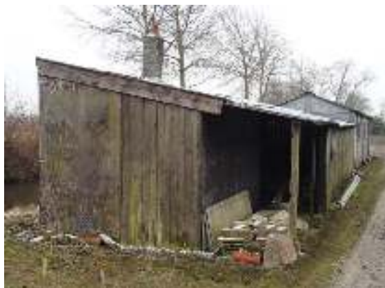
Noordoostgevel houten schuur
