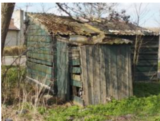
Zuid en Oostgevel pomphok
