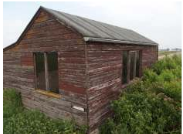
Noordwest en zuidwestgevel
