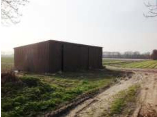
Zuidoost- en noordoostgevel (M.B.)
