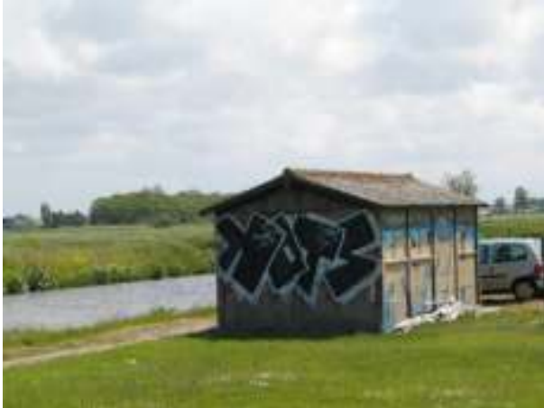
Noordwest- en zuidwestgevel
