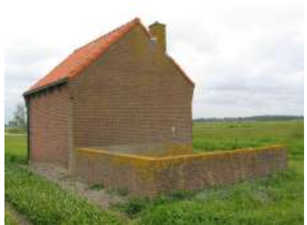
Noordwestgevel en noordoostgevel
