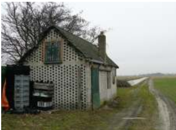
Zuidoostgevel en noordoostgevel in oorspronkelijke staat
