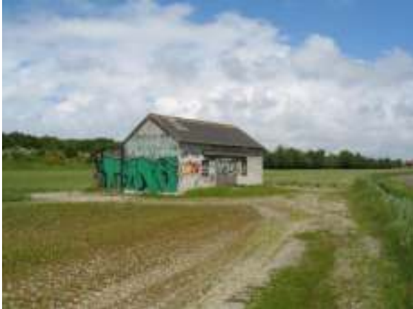
Zuidwestgevel en zuidoostgevel
