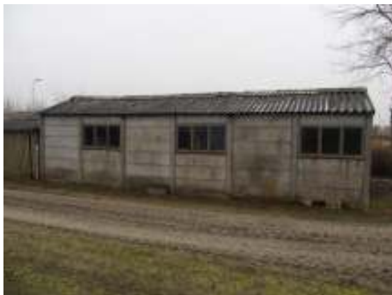
Noordwestgevel betonnen schuur
