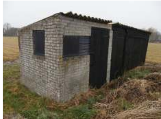
Zuidwest- en zuidoostgevel
