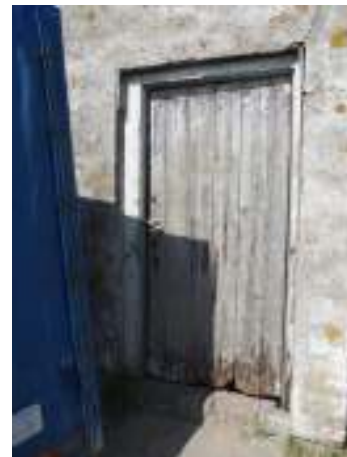
deurkozijn in oostgevel
