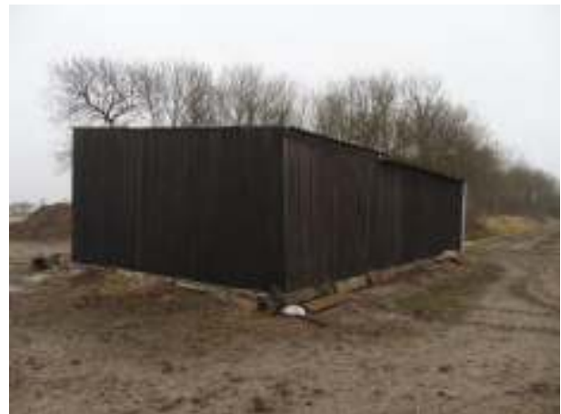
Noordwest- en zuidwestgevel
