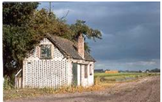
Zuidoostgevel en noordoostgevel in oorspronkelijke staat
