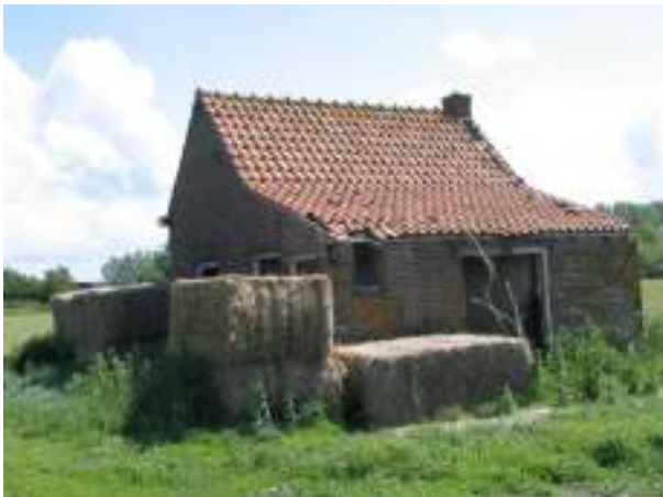
Noordwestgevel en noordoostgevel
