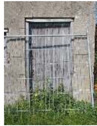
detail rechter deurkozijn
