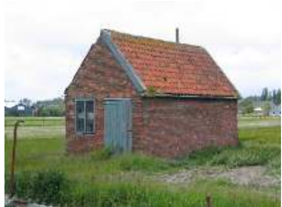
Zuidoostgevel en noordoostgevel
