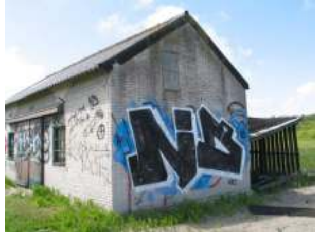
Zuidoostgevel en noordoostgevel
