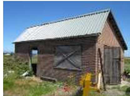
Zuidwestgevel - links toegang tot schaftruimte
