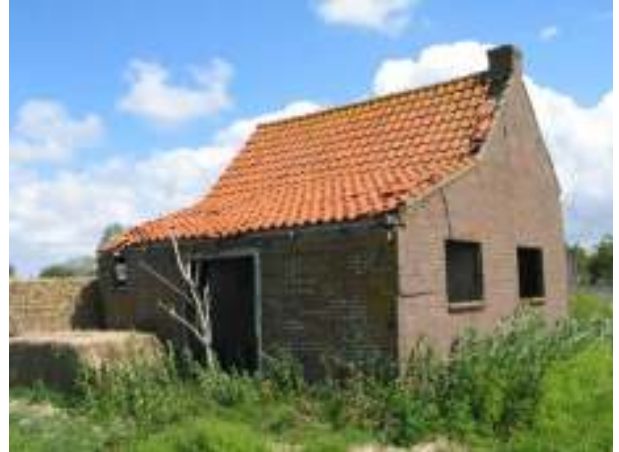
Zuidwestgevel en noordwestgevel
