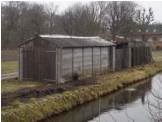
Zuidwest- en zuidoostgevels
