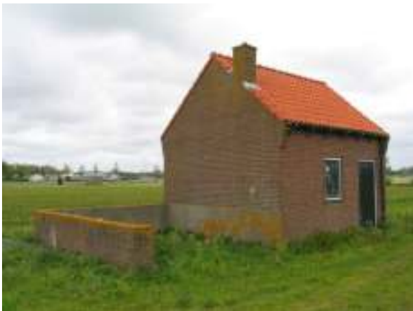
Zuidwestgevel en noordwestgevel
