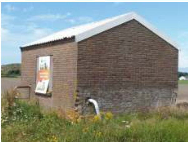
Zuidwestgevel en Zuidoostgevel
