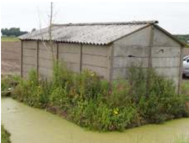
Zuidwestgevel en Zuidoostgevel
